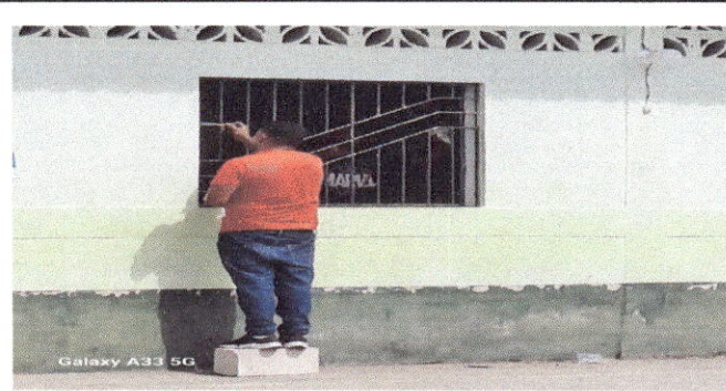
Foto 3: .Ventanas: mantenimiento a balcón de metal, en módulos 1 y 2 en aulas.
