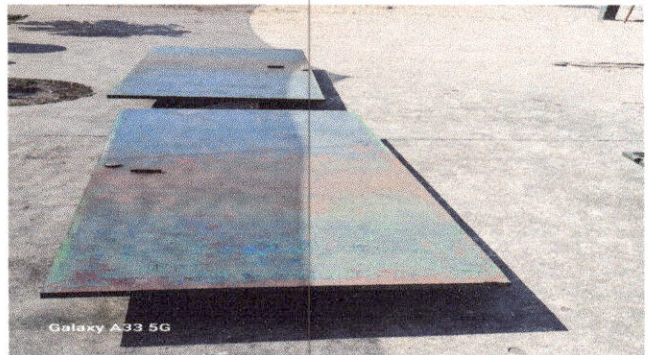
Foto 2: Puertas de metal: Mantenimiento a estructura (lijado, cambio de tubo, cepillado, sujeciones, aplicación de pintura), en el módulo 1 y 2 de aulas.
