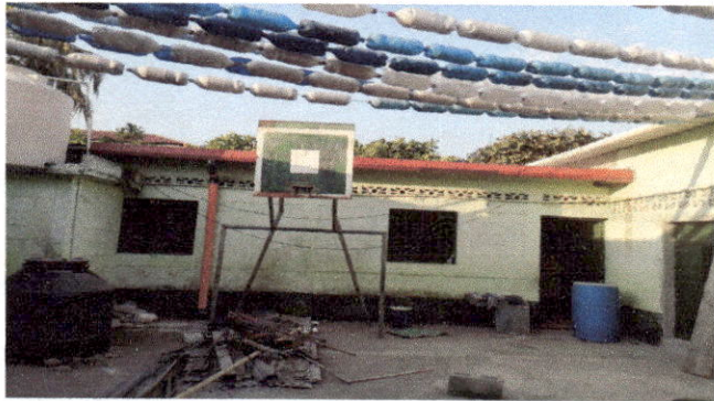
Foto 13: Canales y bajadas de agua pluvial: Sustrucción de canal de PVC por canal de metal y sustrucción de bajada de agua pluvial de PVC del módulo 1 de aulas.
