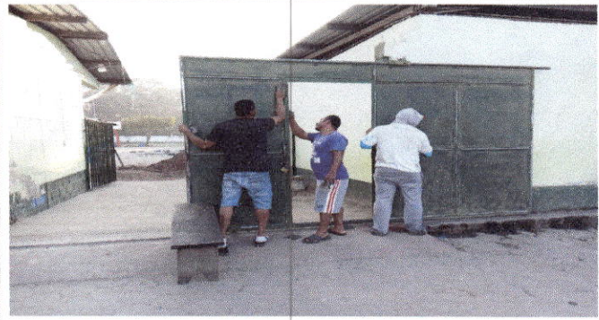
Foto 8 Puertas: Mantenimiento de portones de metal, en entrada principal.
