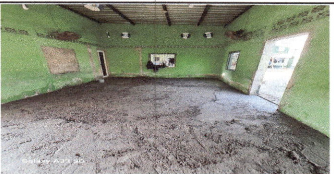
Foto 6: Piso: sustitución de piso de torta de concreto por piso cerámico en módulo 2 en aulas.
