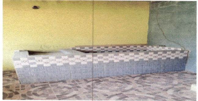
Foto 14: Reparación o sustrucción de azulejos: Sustrucción de azulejos en pila de la cocina
