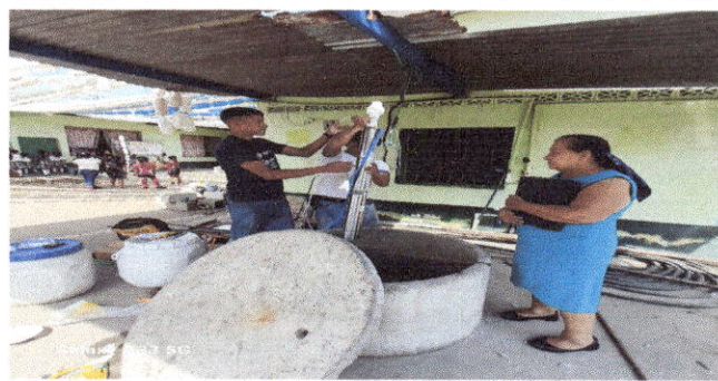
Foto 11 Reparación y mantenimiento de cisternas/ depósitos de agua: sustitución de bomba de agua.
